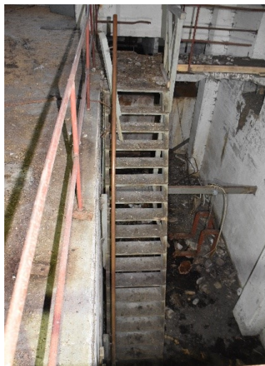
Figur 10. Trätrappa ner till den nedre delen av källaren.
