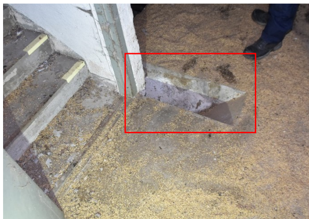
Figur 9. Bild tagen i övre delen av källarplan där trappan mynnar ut och där ett hål i golvet syns direkt utanför trappan.
