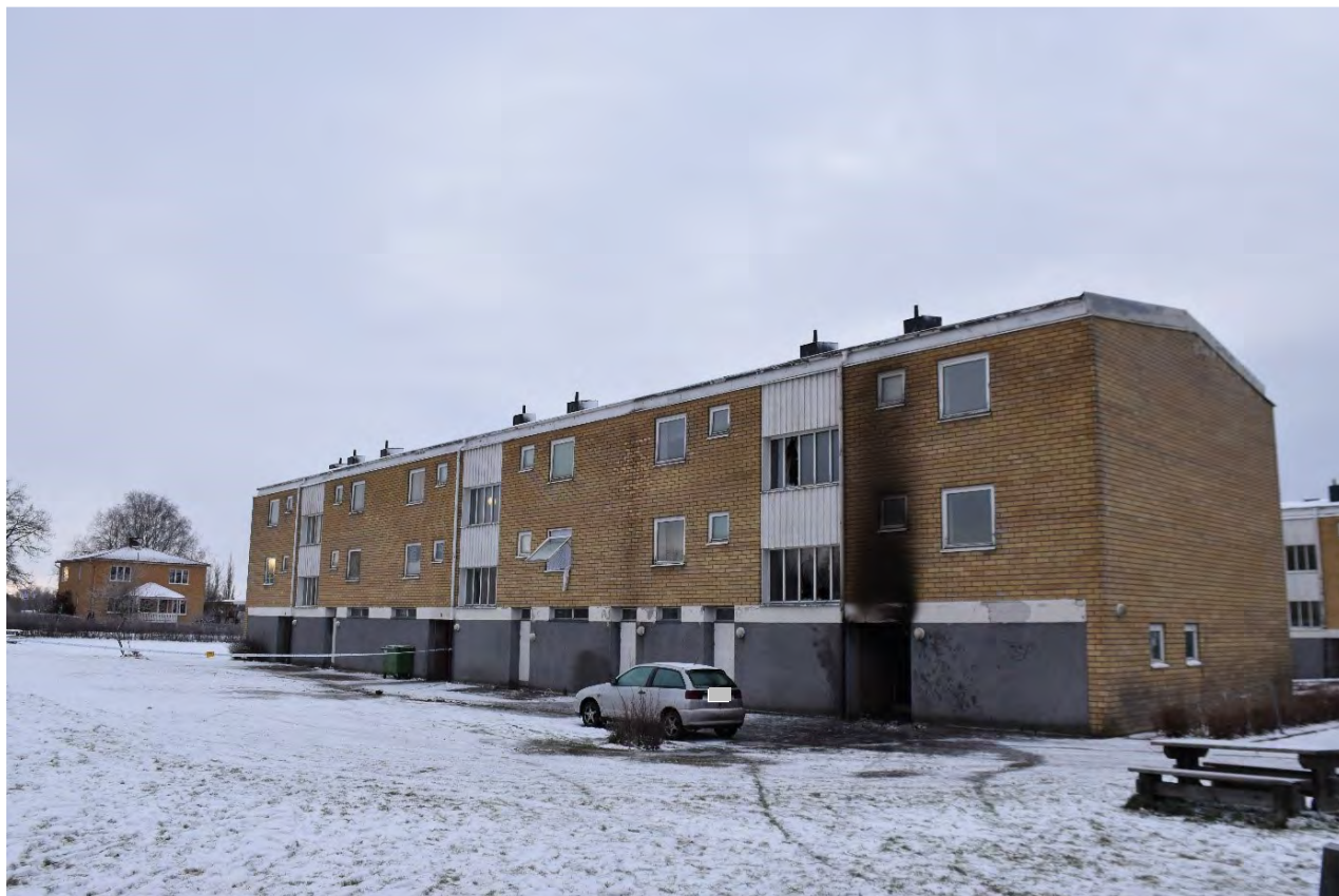
Figur 1. Byggnadens östra fasad, med det brandutsatt trapphuset, 6 C längst till höger.
