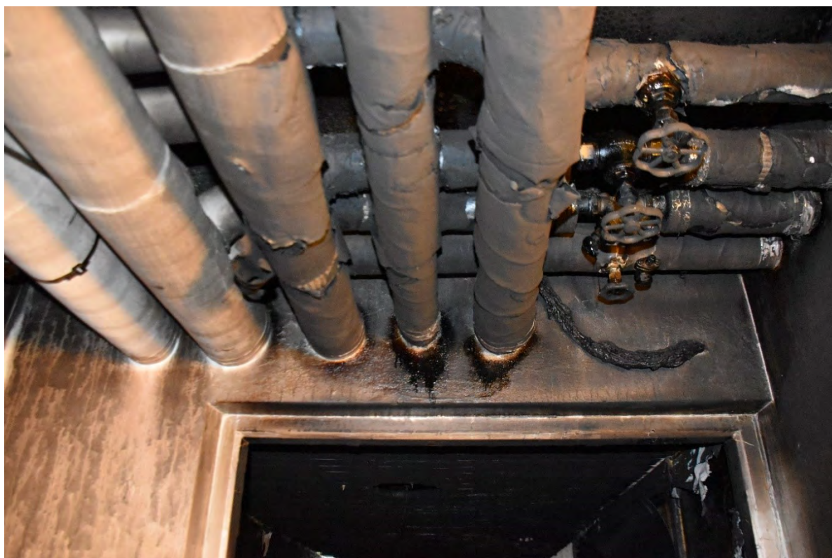
Figur 12. Brandcellsgräns mellan korridor i markplan och trapphus 6 C.
