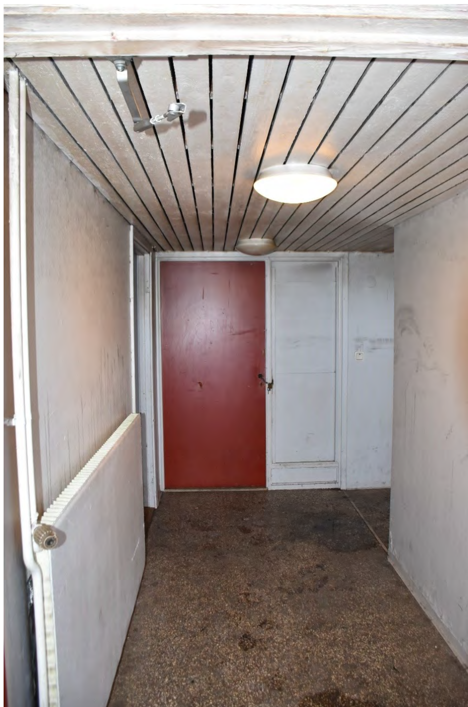
Figur 2. Foto som visar nedpendlat innertak i trapphus 6 B
