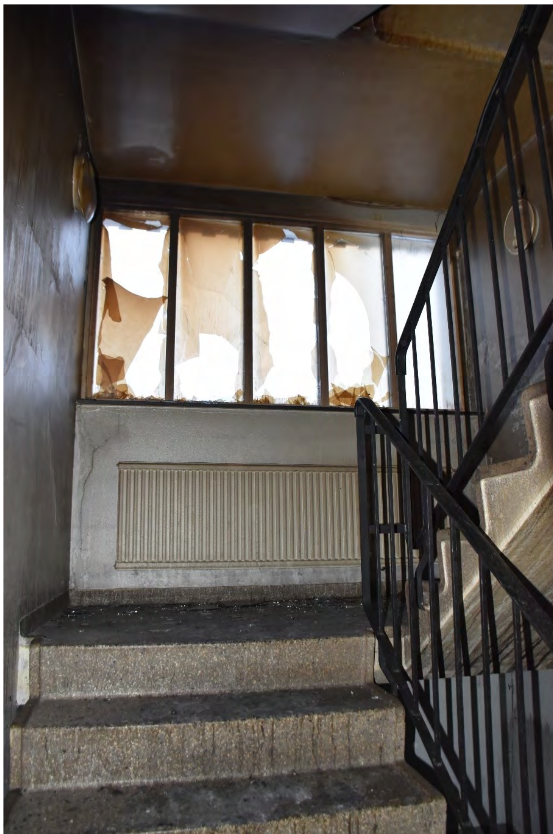
Figur 14. Trapphus 6 C. Foto taget från markplanet.
