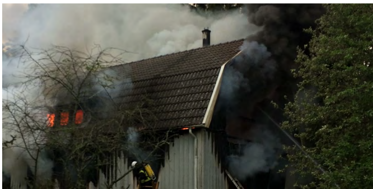
Figur 19. Bild som visar hur rökspridningen kan se ut då råspont förekommer i takkonstruktionen. Källa: Räddningstjänsten Västra Skaraborg.
