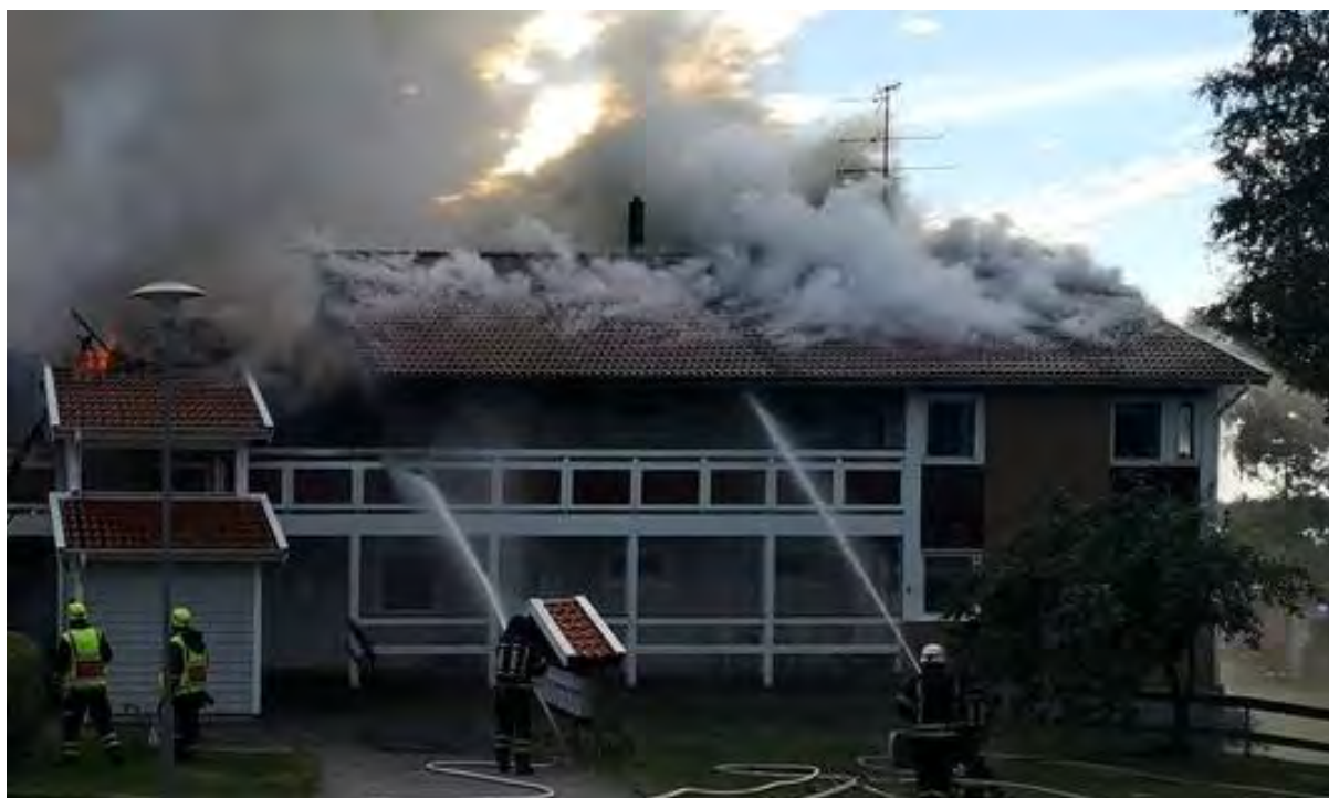
Figur 18. Rökspridning mellan takpannorna på stora delar av taket kan indikera att taket är byggt utan råspont
