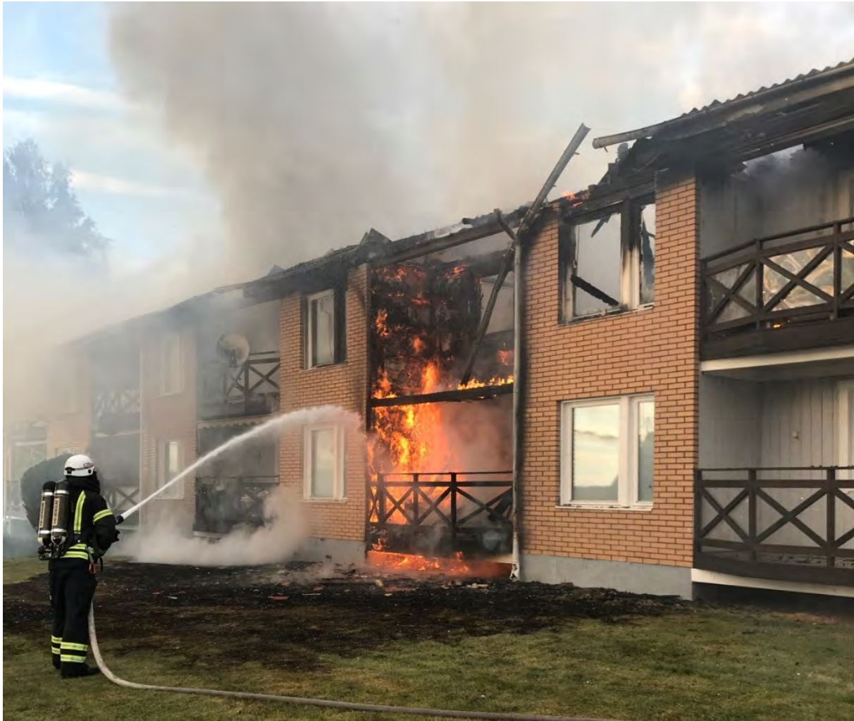
Figur 9. Bild från västra långsidan (18:47 ca 47 min efter att branden upptäckts)
