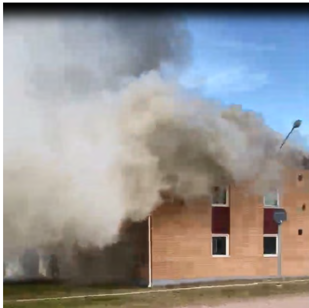
Figur 7. Bild från filmklipp från byggnadens södra gavel (ca 18:19:00, 19 min efter att branden upptäckts). Foto: Privat
