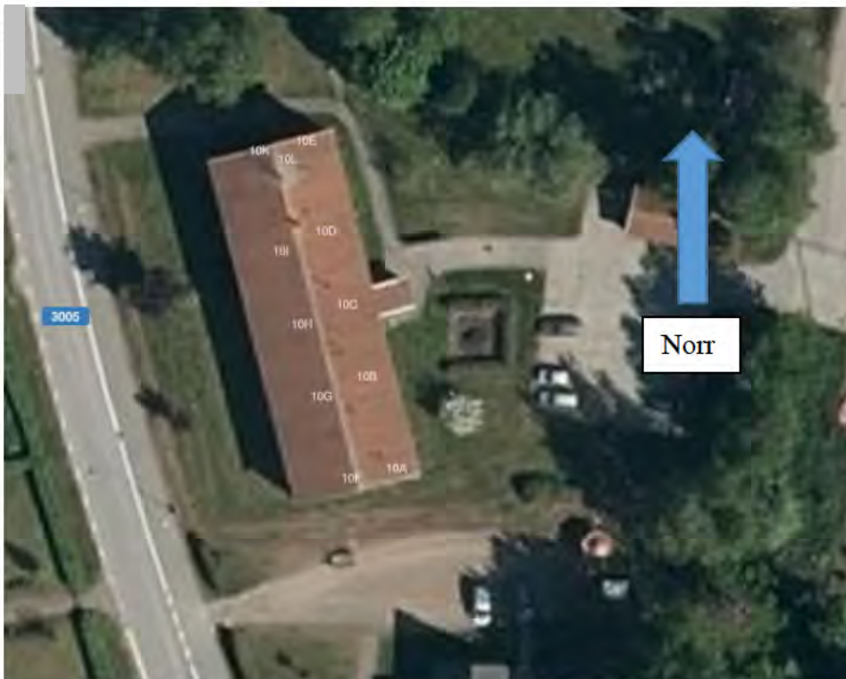
Figur 2. Översiktbild av den branddrabbade byggnaden.
